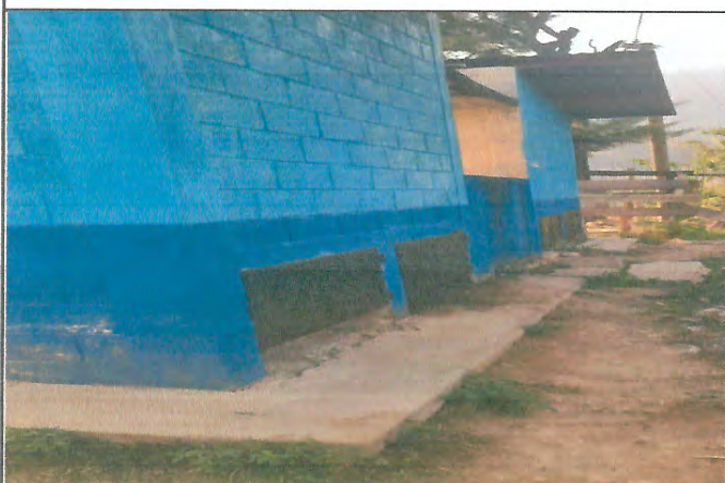
Foto 3: Mejoramiento de servicios sanitarios
