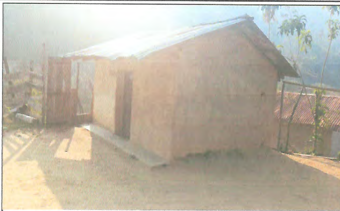
Foto 1: mejoramiento de aula.
